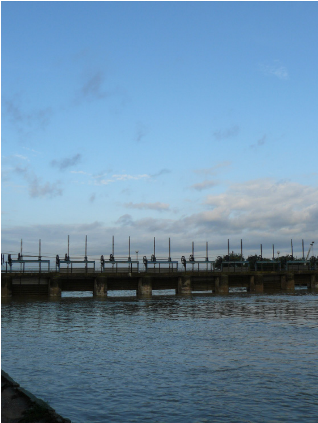
Imatge 15: Les goles o canals de desguàs de l'Albufera, com la Gola del Pujol, disposen d'uns sistemes de comportes que eviten que l'aigua salada arribe a l'estany i produísca danys als cultius d'arròs. Aquestes comportes s'obrin per a facilitar el desguàs de l'Albufera i els arrossars, i també per a possibilitar l'entrada i eixida de peixos —llisses, anguiles i lobarros, principalment—. I es tanquen quan l'arrossar ha de romandre inundat i per a evitar l'entrada de l'aigua del mar durant els temporals. El polèmic i controvertit maneig d'aquestes comportes depèn de la Junta de Desagüe, una entitat representada només per agricultors procedents de les vuit fronteres de L'Albufera: València, Alfafar, Massanassa, Catarroja, Albal, Silla, Sollana i Sueca.
