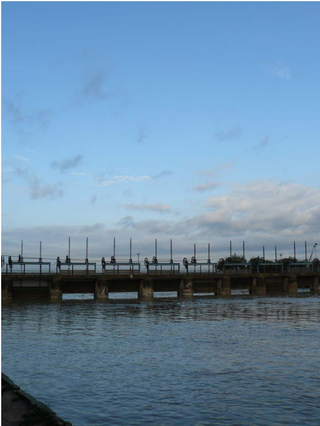
Imagen 15: Las «golas» o canales de desagüe de L'Albufera, como éste de El Pujol, cuentan con un sistema de compuertas que evitan que el agua salada entre a la laguna y produzca daños a los cultivos de arroz. Estas compuertas se abren para facilitar el desagüe de la laguna y los arrozales, y también para posibilitar la entrada y salida de peces —llisas, anguilas y lubinas, principalmente—. Y se cierran cuando el arrozal debe permanecer inundado y para evitar la entrada del agua del mar durante los temporales. El polémico y controvertido manejo de estas compuertas depende de la Junta de Desagüe, una entidad representada sólo por agricultores procedentes de las ocho fronteras de L'Albufera: Valencia, Alfajar, Massanassa, Catarroja, Albal, Silla, Sollana y Sueca.
